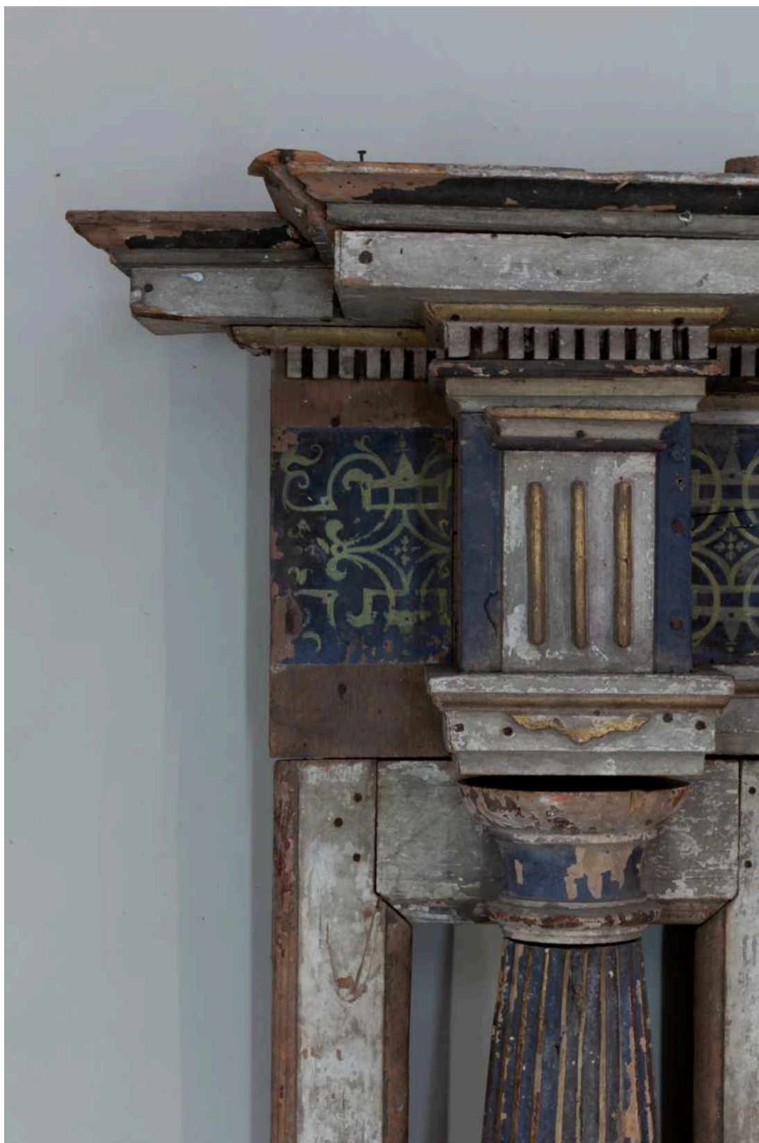
Stav před restaurováním - architektura (architráv) - detail poškození
