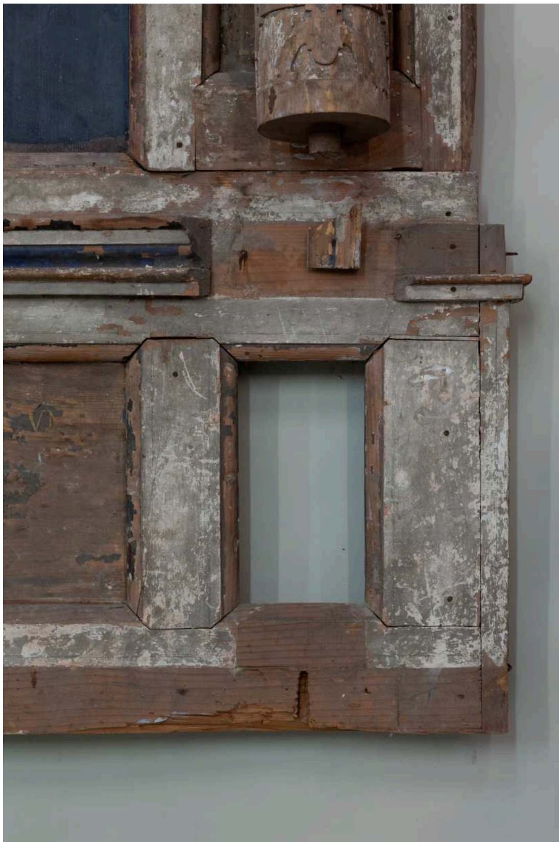
Stav před restaurováním - architektura (konzole) - absentující část
