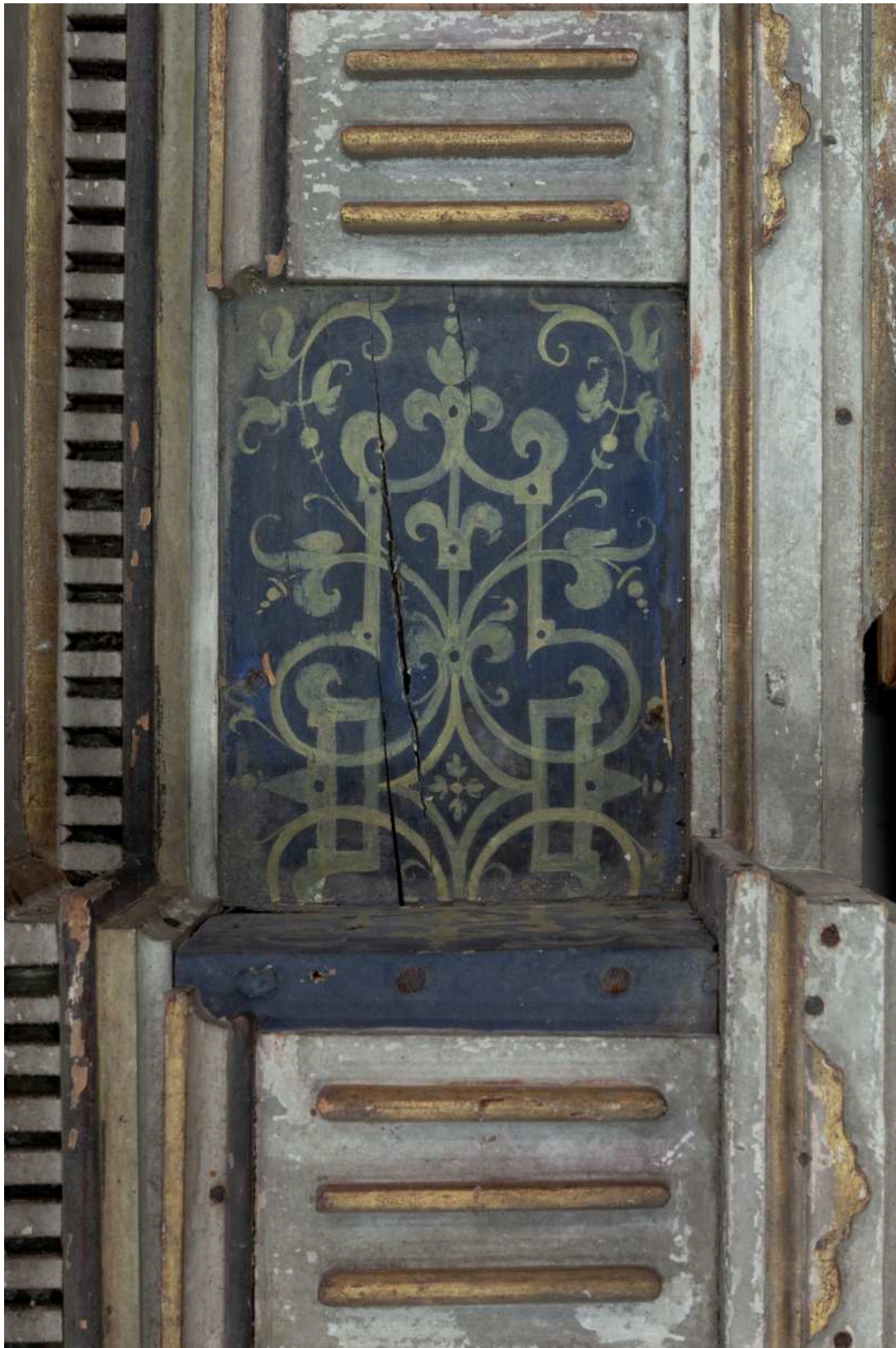
Stav před restaurováním - architektura (architráv) - detail poškození
